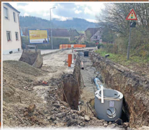
Offene Bauweise des Kanals
