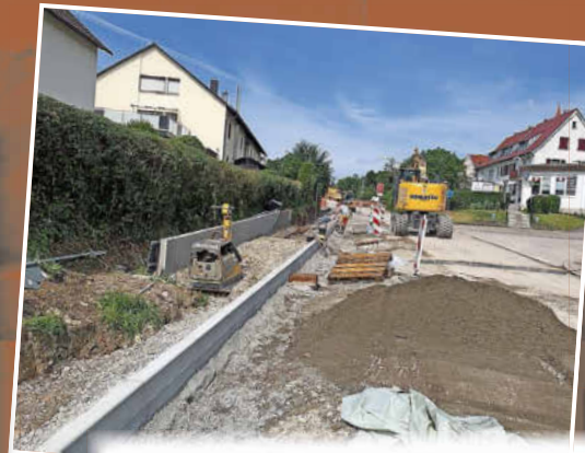
Erstellung des Gehweges von der Gartenstraße zum Reutter-Areal
