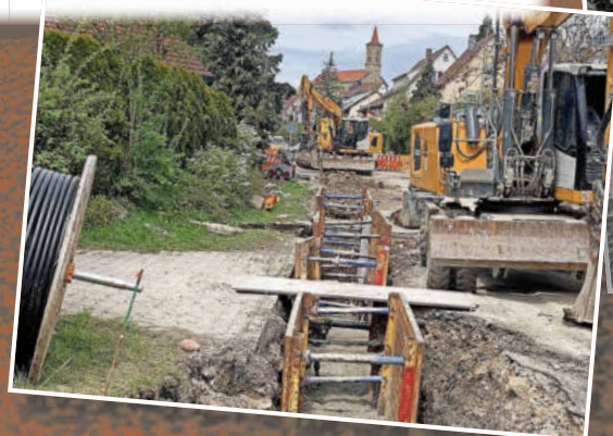
Offene Bauweise des Kanals mit der neuen Verlegung des Regenwasserkanals
