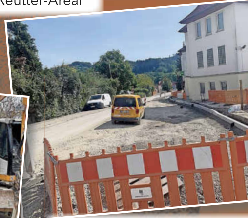
Erstellung der neuen Abbiegespur am Reutter-Areal
