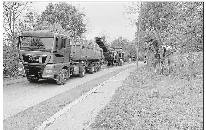
Der Abschnitt „Im Schönbühl“ in Richtung Uttenhofen ist seit 25.10.2021 voll gesperrt und die Asphalterneuerung in vollem Gange. In diesem Zuge werden auch die beiden Bushaltestellen und die Querungshilfe barrierefrei umgebaut.
