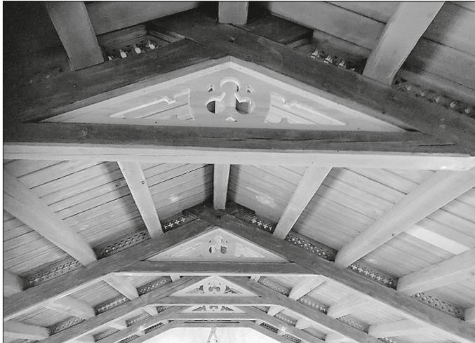
Die neu gefertigten Ornamente wurden in die Deckenkonstruktion eingebaut. Elektriker, Maler und Zimmermann sind weiterhin in unserer Kirche tätig.
