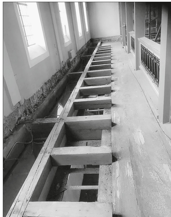
Die Empore ist bereit, neu aufgebaut zu werden.
