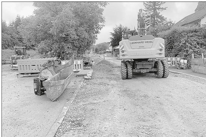
Momentan werden Tiefbauarbeiten für die Straßenentwässerung im Abschnitt von Gaildorf kommend ausgeführt. In diesem Abschnitt sind bereits zum Großteil die Vorbereitungen zum Setzen der Bordsteine abgeschlossen. Im Folgenden wird die Fußgängerampel „Gartenstraße“ barrierefrei umgebaut und der Gehweg in Richtung Reutter-Areal hergestellt.
