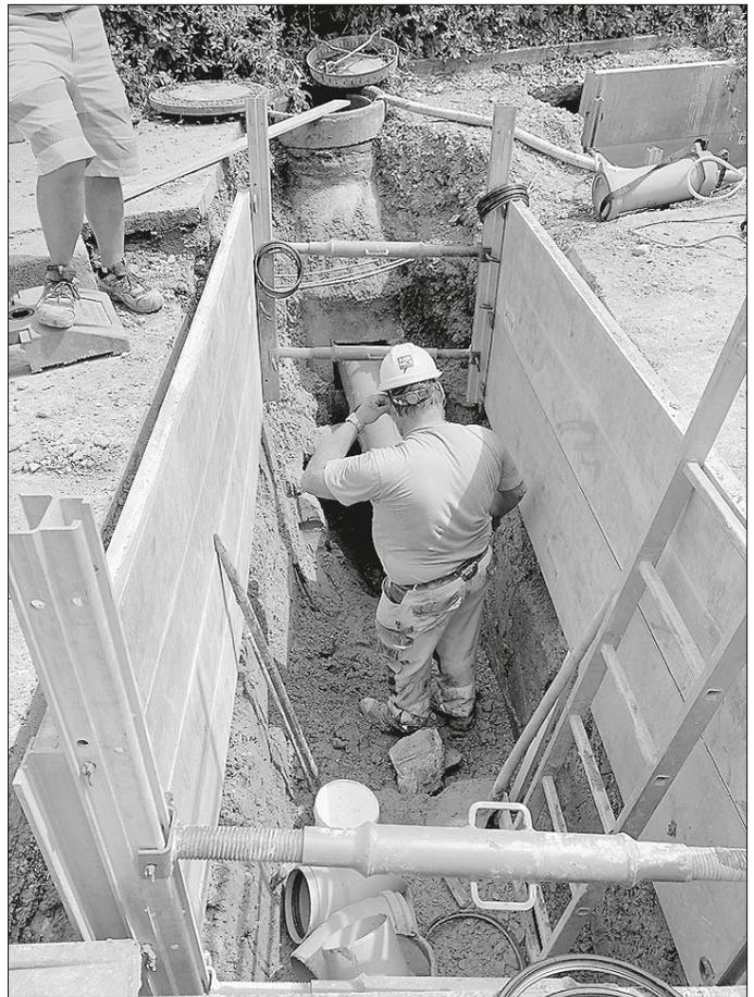
Momentan werden Straßenbauarbeiten und Kanalauswechslungen im Abschnitt von Gaildorf kommend ausgeführt. In diesem Abschnitt laufen bereits die Vorbereitungen zum Setzen der Bordsteine. Des Weiteren wird ein neuer Gehweg von der Gartenstraße in Richtung Reutter-Areal hergestellt.
