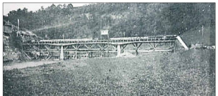
Feldwegbrücke im Bau 1938/39
