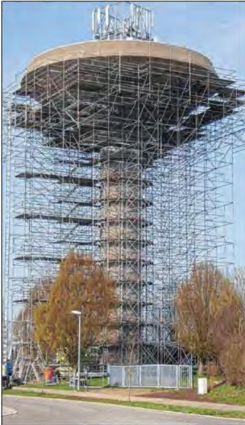
Die aktuelle Technik des Gerüstbaus kann derzeit am Wasserturm in Uttenhofen bestaunt werden, schreibt Günter Seybold, der auch das Foto geschossen hat. Die Biberwasserversorgungsgruppe lässt das Dach des Wasserturms und den Gebäudekörper, der aus Beton gebaut ist, sanieren. Ein Arbeitsplatz nur für absolut Schwindelfreie, meint Seybold, der in Westheim wohnt.
