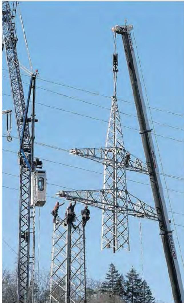
Das Unternehmen Netze BW tauschte gestern den Hochspannungsmast am Umspannwerk Westheim aus. Die riesige Stahlgitterkonstruktion ist 44 Meter hoch und 23 Tonnen schwer.
