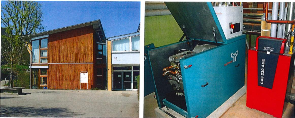
Im Heizungskeller der Grundschule von Rosengarten (links) befindet sich das Blockheizkraftwerk (rechts in Grün), das die Wärmeversorgung für die Schule und die angrenzenden Gebäude übernimmt.
