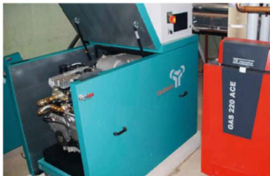
Im Heizungskeller der Schule steht das Blockheizkraftwerk, das mit Erdgas Wärme auch für angrenzende Gebäude erzeugt. Foto: privat
