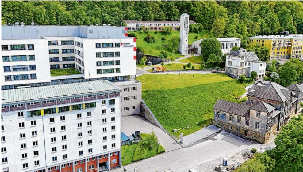
Diak-Gelände in Schwäbisch Hall: Auf dem Baufeld rechts neben dem Bettenhaus soll der zweite Neubauabschnitt platziert werden.
