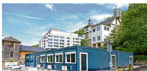
Auf dem Klinikgelände in Hall entsteht das Interims-Kinderland. Die Stadt zahlt einen wesentlichen Teil, der Landkreis stellt die Fläche. Ungeklärt ist, ob die Stadt nun auch die Trägerschaft übernimmt.
