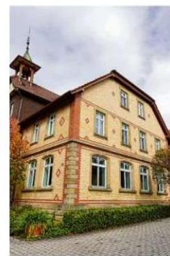
Das Rosengartener Rathaus könnte in den nächsten Jahren auch mit PV-Technik ausgerüstet werden. Foto: Beatrice Schnelle
