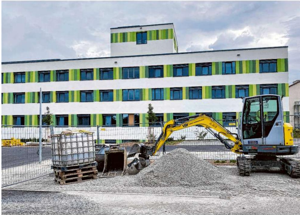
Das Klinikum Crailsheim wird aktuell um einen Anbau erweitert. Hier zieht die gynäkologische Abteilung mit drei Kreißsälen ein, die geriatrische Abteilung sowie eine komfortabel ausgestattete Wahlleistungsstation mit gehobenem Service. Außerdem gibt es einen Hubschrauberlandeplatz auf dem Dach. Der Erweiterungsbau geht zu Beginn des neuen Jahres in Betrieb. Foto: Christine Hofmann
