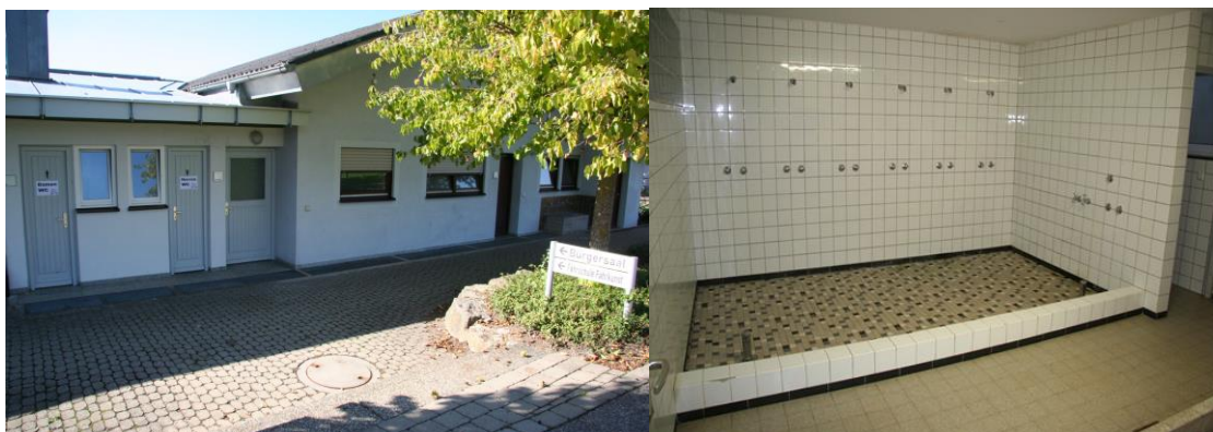
Die Maßnahmen an der Rosengartenhalle stellen die größte Investition der Gemeinde in 2016 dar.
