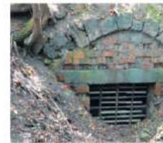
Der ehemalige Lagerkeller ist mit einem Eisengitter gesichert.
