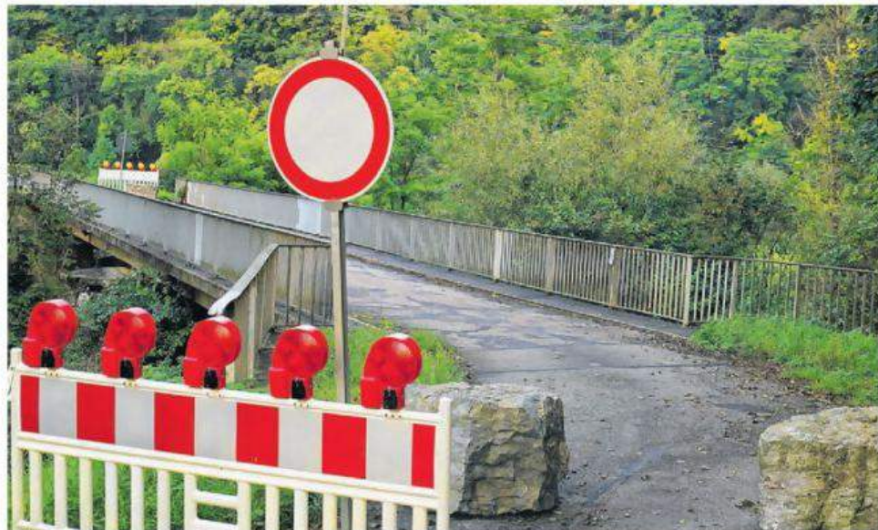
Seit Anfang 2015 ist die marode Brücke bei der Neumühle für Kraftfahrzeuge gesperrt. Das wird noch eine ganze Weile so bleiben. Foto: cito
