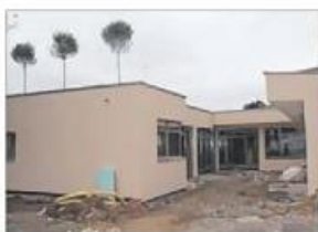
Die Arbeiten am Möckel'schen Kindergarten sind in vollem Gange.
