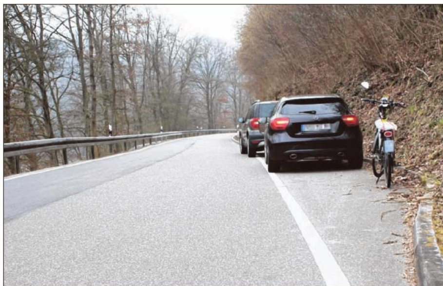
Die Straße zwischen Tullau und Steinbach ist mit nur 5,50 Meter Breite gefährlich schmal für Radfahrer. Viele Tullauer wünschen sich einen Radweg, der in den Hang hinein gebaut werden könnte. Foto: Katharina Gottschalk
