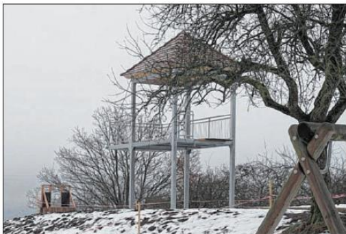
Noch steht der Turm des Projekts am Rosengartener Kelterbuckel ohne Verkleidung da – deshalb ist nur das Gerüst zu erkennen. Foto: Oliver Färber
