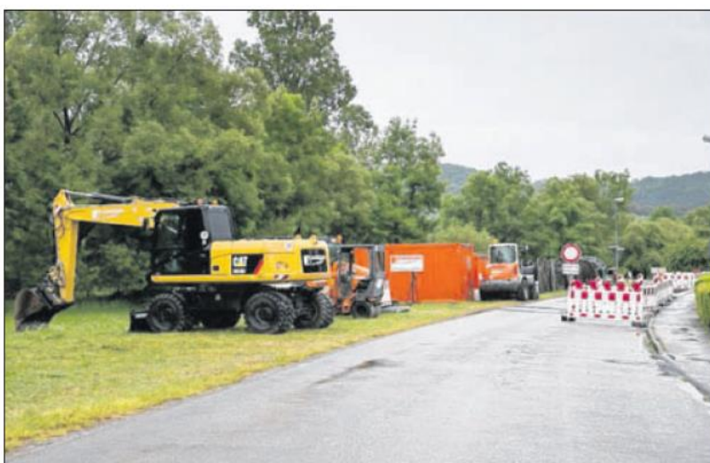
Die Wasser- und Stromleitung in Richtung Westheim wird erneuert. Eine Abwasserleitung könnte gleich mit verlegt werden.
