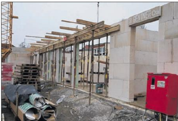
Der Möckel'sche Kindergarten in Westheim ist 1956 entstanden. Zurzeit wird das Gebäude ausgebaut.
