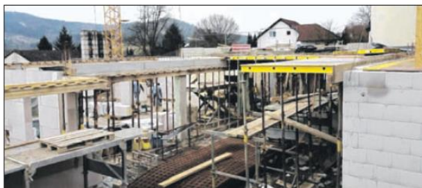
Die Erweiterung des Möckel'schen Kindergartens wird die Gemeinde Rosengarten knapp eine Million Euro kosten. Privatfoto
