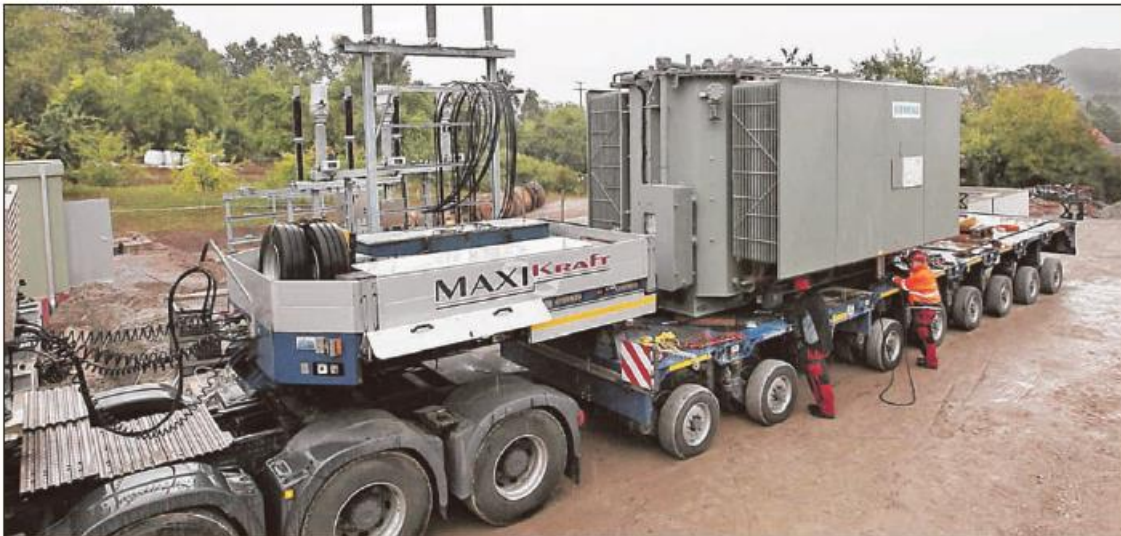
Mit einem Schwertransport wird am Donnerstag ein 76 Tonnen schwerer Trafo für das neue Umspannwerk der Stadtwerke Schwäbisch Hall in Westheim angeliefert. Mit der 2,1-Millionen-Euro-Investition soll die Versorgungssicherheit in Hall und den umliegenden Gemeinden verbessert werden. Foto: U&K Arslan
