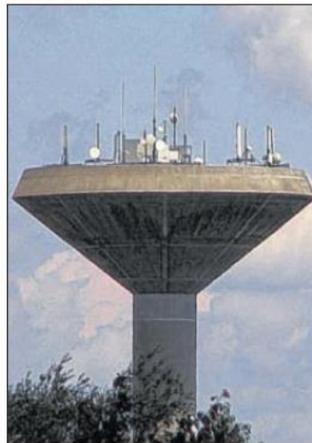
Auf dem Wasserturm in Uttenhofen werden demnächst neue Mobilfunkantennen montiert.
