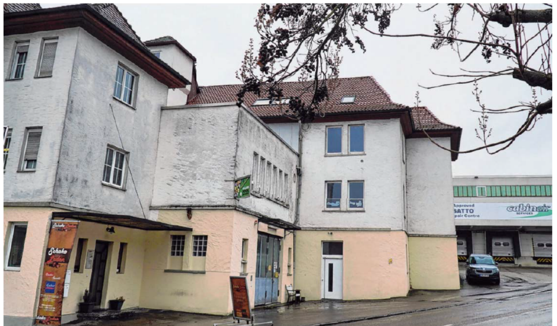
Die Gebäude der Süßwarenfabrik Reutter gehören seit 1913 zum Ortsbild von Westheim. Bald sollen die alten Industriebauten einem modernen Wohn- und Einkaufsgebiet Platz machen.
