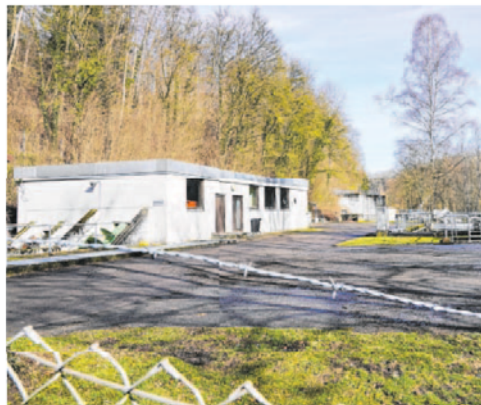
Die Rosengartener Kläranlage gehört zu den größten Stromfressern der Gemeinde. Foto: Archiv
