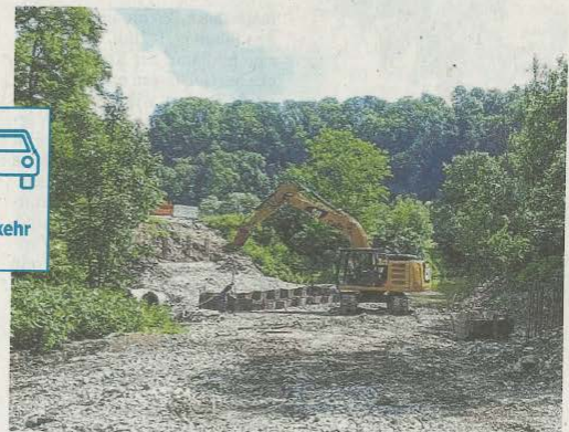
Die Arbeiten für die Kocherbrücke bei Wilhelmshluck sind in vollem Gang. In der Mitte ist die Schalung für das Fundament des Mittelpfeilers zu sehen. Foto: Landratsamt Schwäbisch Hall
