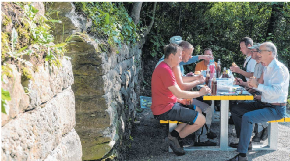
Nach vollendeter Arbeit: Hermann Giebler, Bürgermeister Jürgen König und das Team vom Bauhof beim zünftigen Vesper, mit dem das renovierte Franzosenbrünnele sozusagen „offiziell eingeweiht“ wird.
