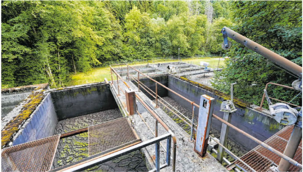
Blick über den Zaun auf einen Teil der Kläranlage in Westheim. Sie ist die größte und älteste der drei bestehenden Kläranlagen der Gemeinde Rosengarten. Foto: Beatrice Schnelle
