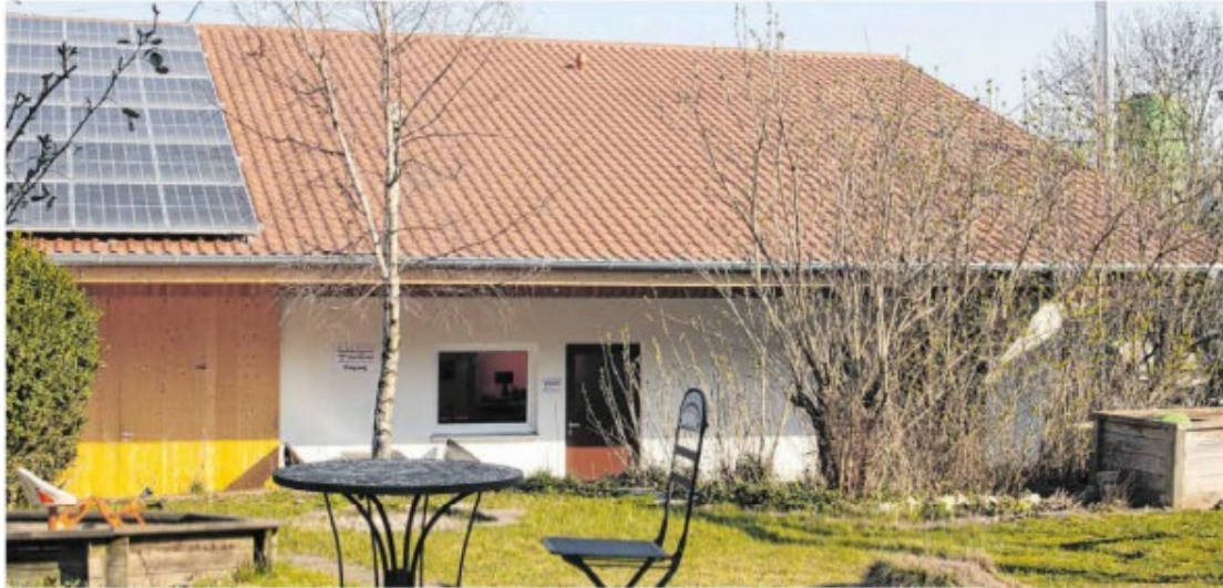
Links im Neubau ist die Scheune, rechts die Metzgerei untergebracht. Auf dem Dach wurde Fotovoltaik installiert. Nach dem Brand im Juni 2019 wird die Landmetzgerei nun wieder eröffnet. Fotos: Claudia Linz
