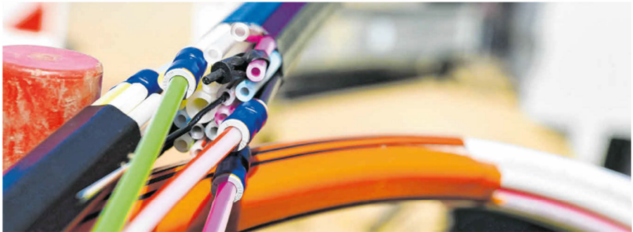
Glasfaserkabel sollen bis in die Häuser verlegt werden. Sechs Millionen Euro Fördergelder flossen bereits nach Rosengarten.
