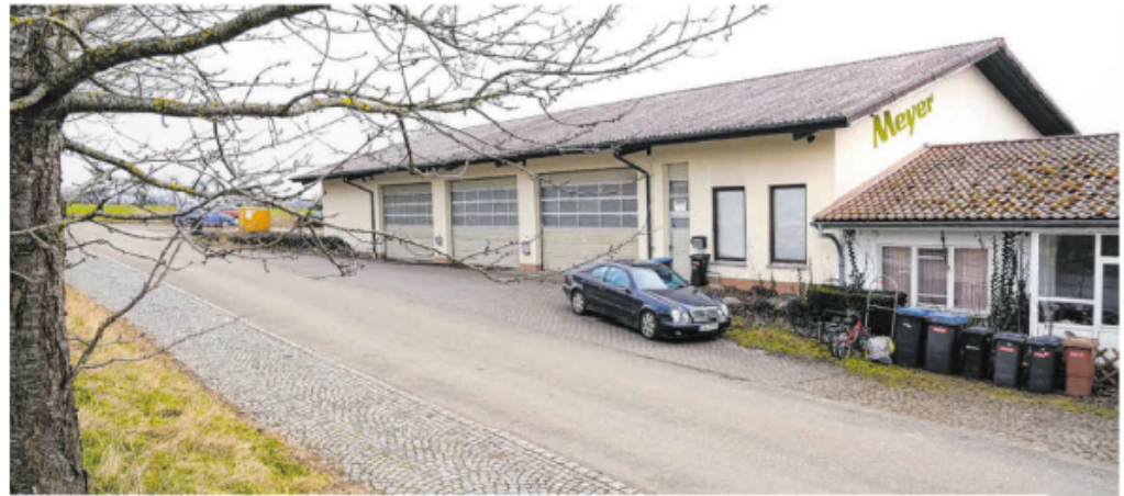
Die Industriehalle des Garten- und Landschaftsbauunternehmens von Gerd Meyer wurde 2009 auf Grund einer Insolvenz versteigert. Sein Sohn Bernhard hat das Gebäude 2018 zurückgekauft. Unter der Halle befindet sich ein stillgelegter Atomschutzbunker. Foto: Beatrice Schnelle
