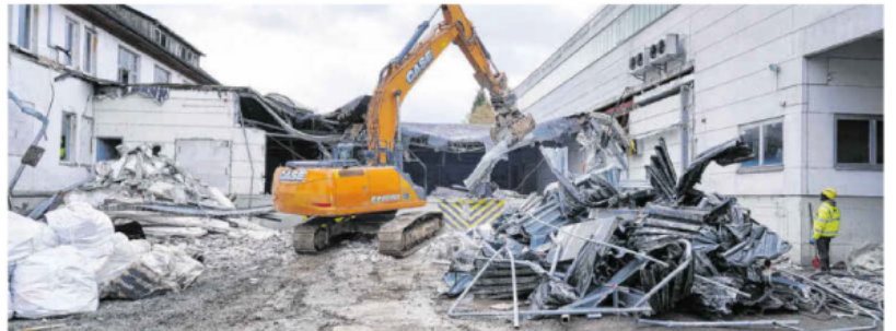
Der Bagger macht schon Teile der ehemaligen Süßwarenfabrik Reutter platt.
