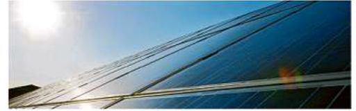
Die erste Freiflächen-Fotovoltaikanlage im Landkreis Hall wurde in Sanzenbach, Gemeinde Rosengarten, installiert. Foto: Archiv
