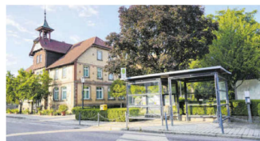
Die Busbucht vor dem Rathaus in Uttenhofen soll barrierefrei umgebaut werden. Foto: Beatrice Schnelle
