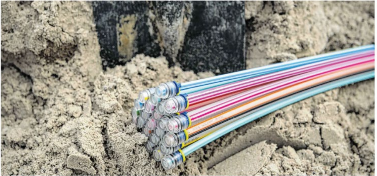
Glasfaserkabel liegen auf einer Baustelle. Immer mehr Bundesbürger bekommen durch diese Leitungen schnellen Zugang zum Internet.
