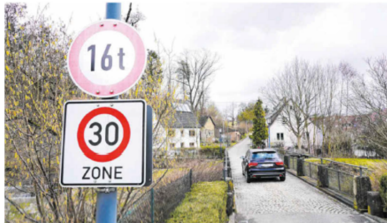
Diese kleine Brücke ist die einzige befestigte Zufahrt zu den bestehenden und eventuell künftigen Wohnhäusern im Kirchklingenweg. Anwohner plädieren dafür, im Zuge einer Neubebauung die Feldwege am oberen Ende der Straße als zusätzliche Zufahrt auszubauen. Foto: Beatrice Schnelle
