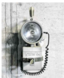
Lesen Notleuchte im Bunker wird von einem handbetriebenen Dynamo mit selbst erzeugtem Strom versorgt.
