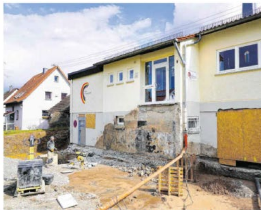
An Ihrer Stelle entsteht ein Anbau, der einen ebenerdigen Zugang zum Gebäude ermöglicht.
