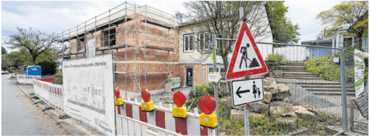
Das Haus des Uttenhofener Kindergartens hat sich stark verändert. Anstelle der ehemaligen Außentreppe ist ein Anbau entstanden, ein ungenutzter Vereinsraum wurde zum dringend benötigten Gruppenraum ausgebaut. Im Januar 2022 soll alles fertig sein. Foto: Beatrice Schnelle
