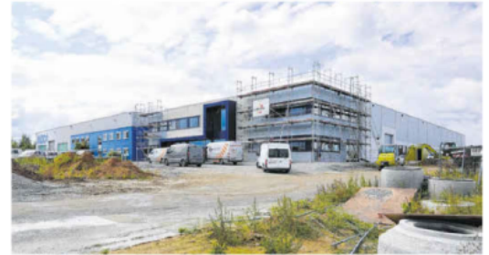
Im November soll der Erweiterungsbau des Unternehmens Aluca im Gewerbegebiet Schollenäcker-West fertig sein. Foto: c/ito
