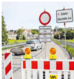
Die Arbeiten auf der B19 sollen im November enden. Foto: gm
