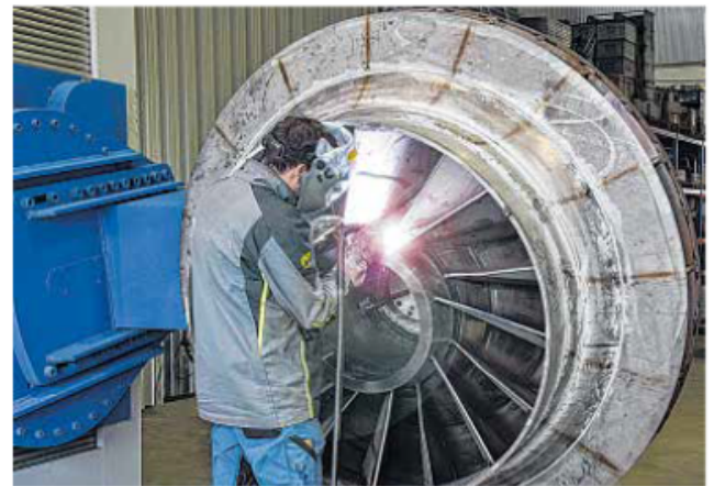
Spezialisten: Die Modifikation von Laufrädern erfordert eine große Erfahrung der Mitarbeiter beim Schweißen, denn die Bauteile bestehen häufig aus Sondermaterialien.
