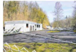
Die Kläranlage im Teilort Westheim. Foto: Archiv
