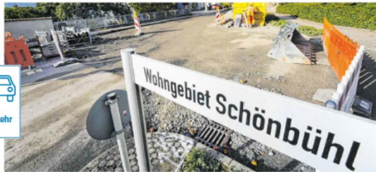
Bis zur Einmündung im Schönbühl ist die B 19 durch Westheim bereits fertig asphaltiert und für Anlieger freigegeben. Jetzt ist der obere Abschnitt der Bundesstraße dran. Er ist darum komplett gesperrt.
