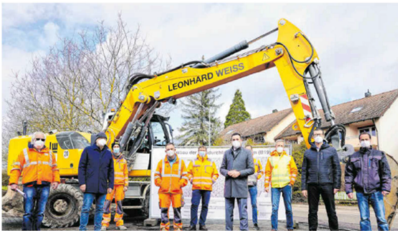
Der erste Bagger ist schon da. Das Bild zeigt Bürgermeister Julian Tausch (Bildmitte) mit Vertretern der am Großprojekt B 19 beteiligten Unternehmen bei der offiziellen Übergabe der Baustelle am Freitag. Mit im Boot sind die Haller Stadtwerke, Kanaltechnik Meyer aus Schwabach, das Büro Grimm Ingenieure aus Ellwangen und das Satteldorfer Bauunternehmen Leonhard Weiss. Foto: Beatrice Schnelle
