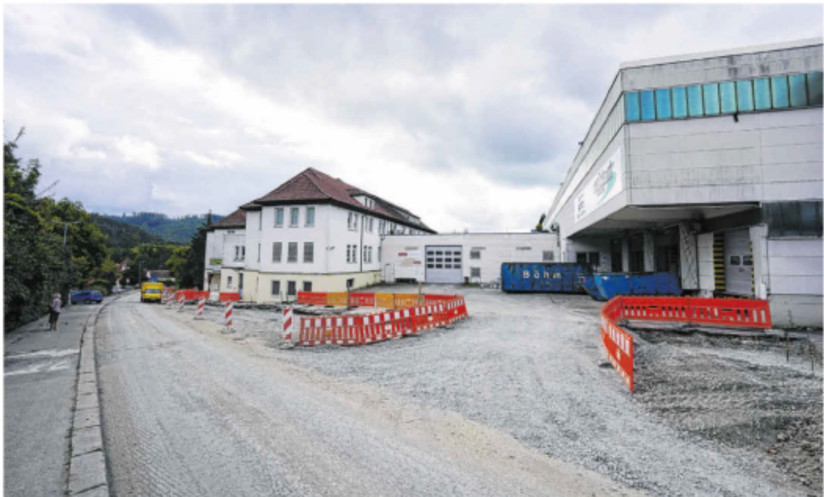
Die Abbiegespur von der Bundesstraße 19 auf das künftige Mischgebiet ist bereits deutlich zu erkennen.
