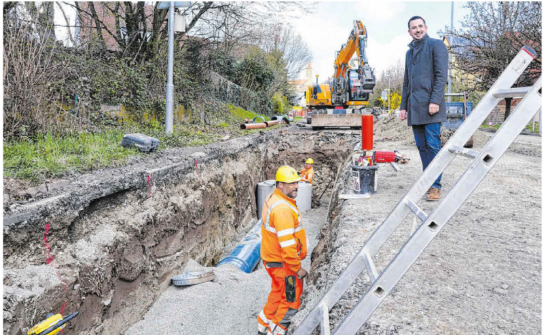
Bürgermeister Julian Tausch (rechts) freut sich über den Fortschritt der Großbaustelle auf der B 19 in Westheim. Bis Jahresende sollen die Sanierung der Kanalisation und der Einbau des neuen Fahrbahnbelags auf der 990 Meter langen Strecke fertig sein. Foto: Beatrice Schnelle
