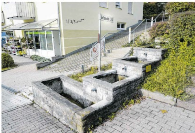
Der alte Brunnen im Schönbühl liegt schon lange trocken. Ein Neubau soll das Wasser wieder sprudeln lassen. Gleichzeitige dient der Brunnen dazu, dem Wasser Kalk zu entziehen, der sonst das Kanalnetz verstopfen könnte.
