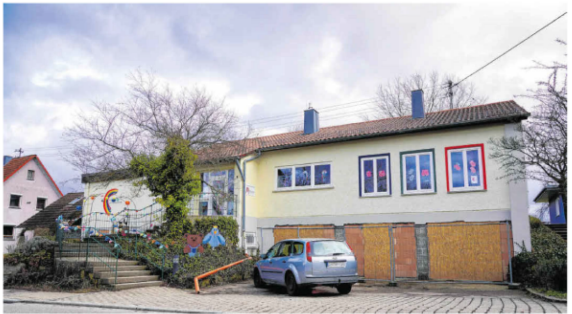
Umbauarbeiten am Kindergarten im Rosengartener Ortsteil Uttenhofen: Wie die neue, mit Fenstern versehene Außenwand vor der ehemaligen Garageneinfahrt aussehen soll, ist schon erkennbar. Foto: Beatrice Schnelle
